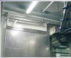
Öffnungen in Brandwänden bei Kühlräumen (+4°C) oder Tiefkühlräumen (-28°C) müssen nicht nur brandschutztechnisch abgeschottet werden, sondern auch isolierend gegen den Kältestrom. Dies kann mit 2 Türen (Isoliertür + Brandschutztür) erfolgen - oder gibt es eine effizientere Lösung?
